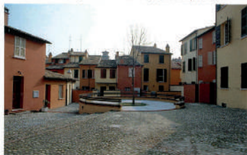
Il cortile interno dell'isolato 36 dopo l'intervento di recupero.
